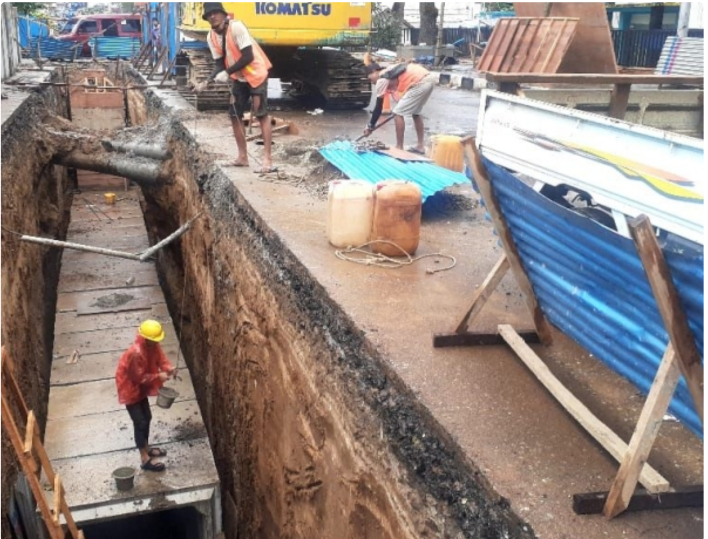
Pekerjaan Drainase Kota Bukittinggi kini telah mencapai 70%
